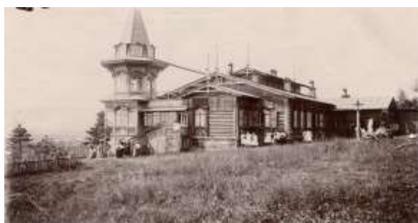
Рис. 11. Вид дачи на высоком берегу Ушаковки. Фото И.А. Подгорбунского (до 1917 г.)
