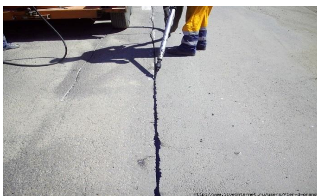
Рис. 4. Герметизация температурных швов цементобетонных покрытий
