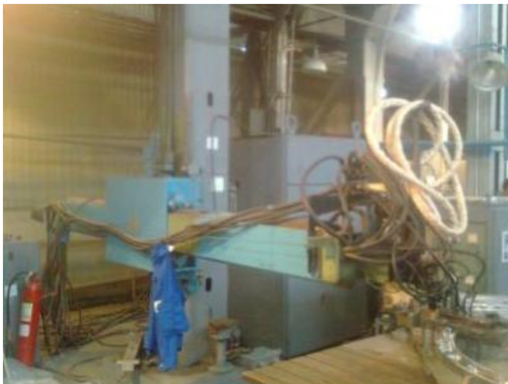
Рис. 2. Установка для сварки погруженной дугой
