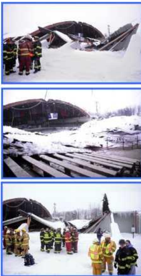
Рис. 2 Частичное обрушение крыши стадиона в г. Ростраверт (США) г. Благовещенск (10.03.2009 г.)
