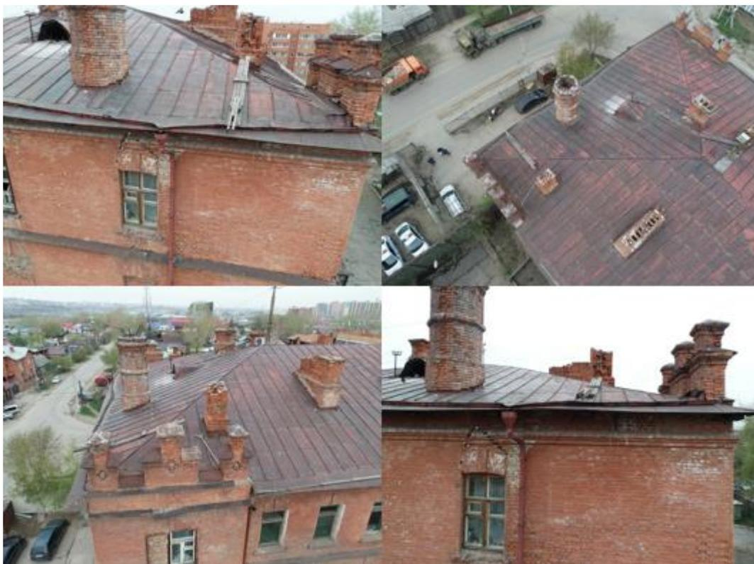
**Фотоснимки фасада и кровли с зафиксированными дефектами**
