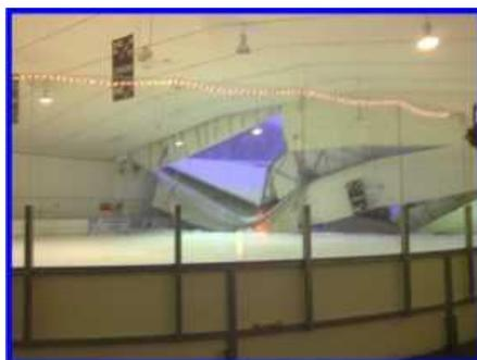
**Рис. 4. Обрушение кровли ледового катка «Полюс», г. Владивосток г. Чусовой, Пермский край (04.12.2005 г.)**
