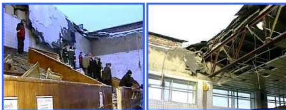
**Рис. 5. Обрушение кровли кирпичного трёхэтажного бассейна «Дельфин», г. Чусовой, Пермский край**
