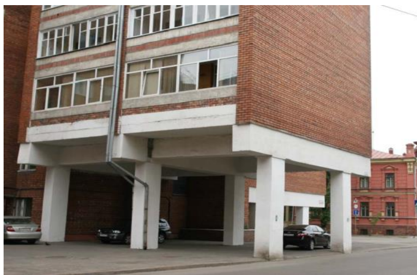
Рис. 4. Дом с квартирами в двух уровнях по улице 5-й Армии
