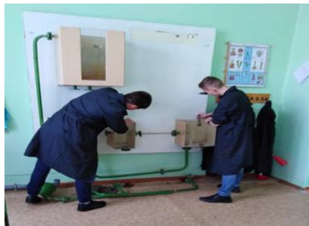
Рис. 1. Демонтаж навесного оборудования
