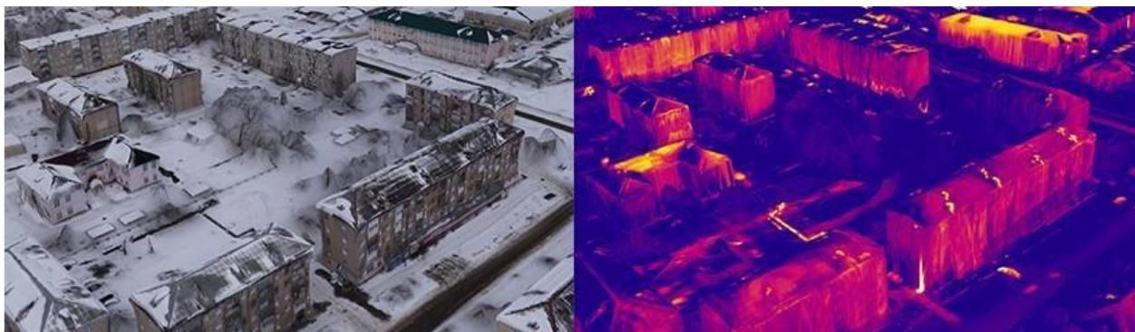
**Рис. 2.** Тепловизионная съёмка ограждающих конструкций группы зданий в посёлке Жилкино г. Иркутска в сравнении с обычным видом
